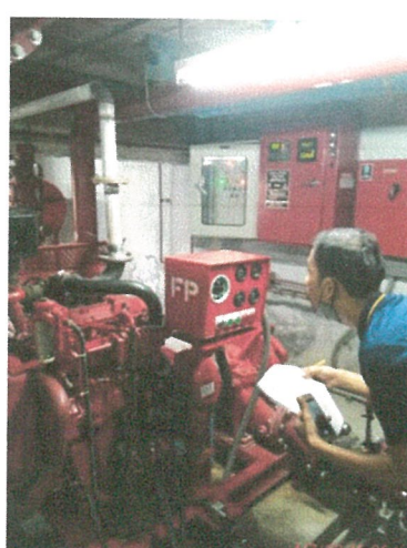
รูปภาพที่ 2.37 การตรวจสอบเครื่องสูบน้ำ
