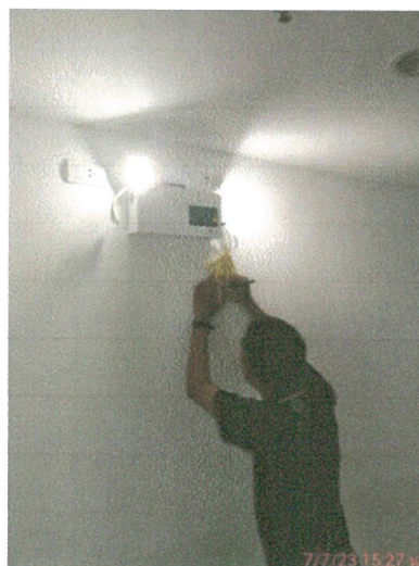
รูปภาพที่ 2.18 การตรวจสอบอุปกรณ์แจ้งเตือนและป้องกันอัคคีภัย
